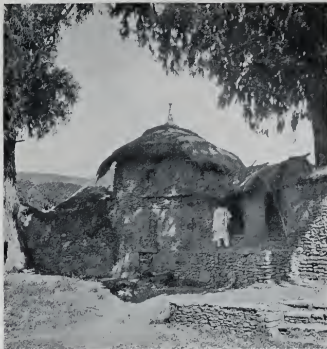
Abb. 230. Priesterhaus in der Nordmauer des Vorderhofes der Zionskirche.
